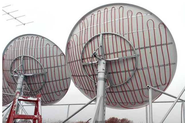
Фиг.4. Антени с отопления по системата DEVI
